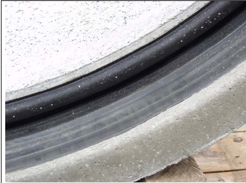
Abbildung: Detail oben: Sandgefüllter Lastübertragungsschlauch, verankert unten: integrierte Kompressionsdichtung BS 2000
