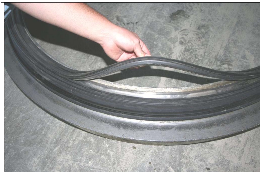
Abbildung: Untermuffe mit Nut, Dichtung BS 2000 aufgezogen, Montage des mit Sand gefüllten Schlauchs
